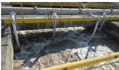
曝気槽の水質点検
